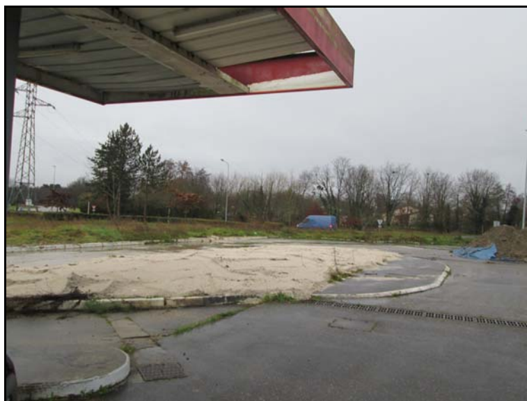
Figure 13 : Etat du site à l'issue des travaux de dépollution et du remblaiement de la fouille (06.123.RA.008.01.fig12)
