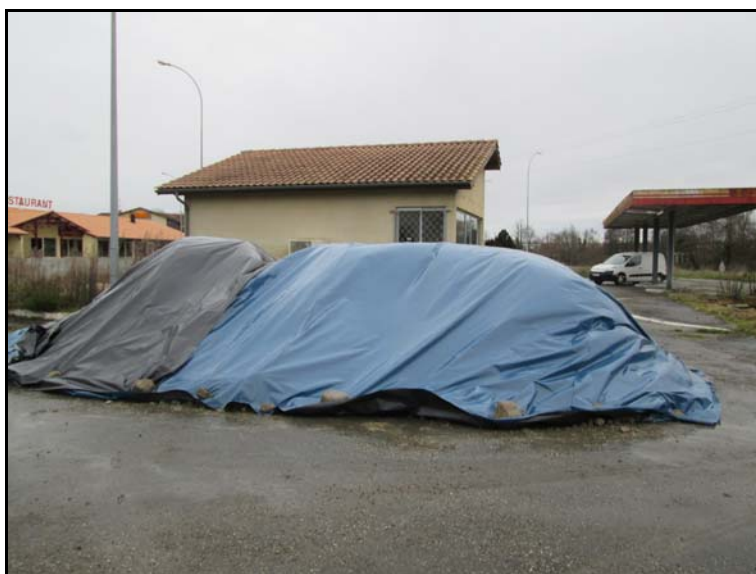
Figure 8 : Zone de stockage de terres souillées (06.123.RA.008.01,fig7)
